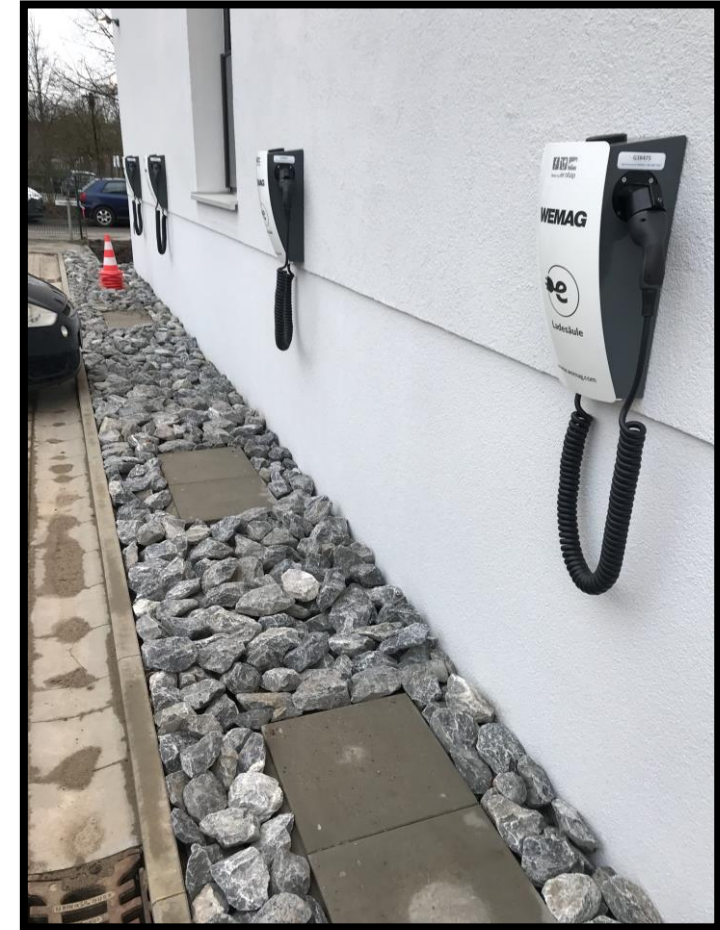
Montage an Außenwand
